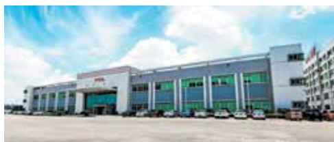
3 Завод в г. Цзюцзян (2 млн. комплектов кондиционеров)
