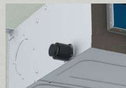
Вывод дренажа с двух сторон
